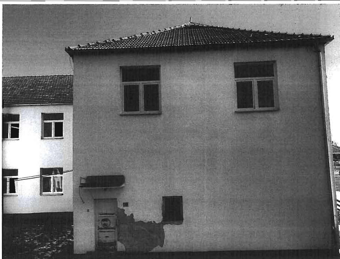
Фотографије фасада објекта
