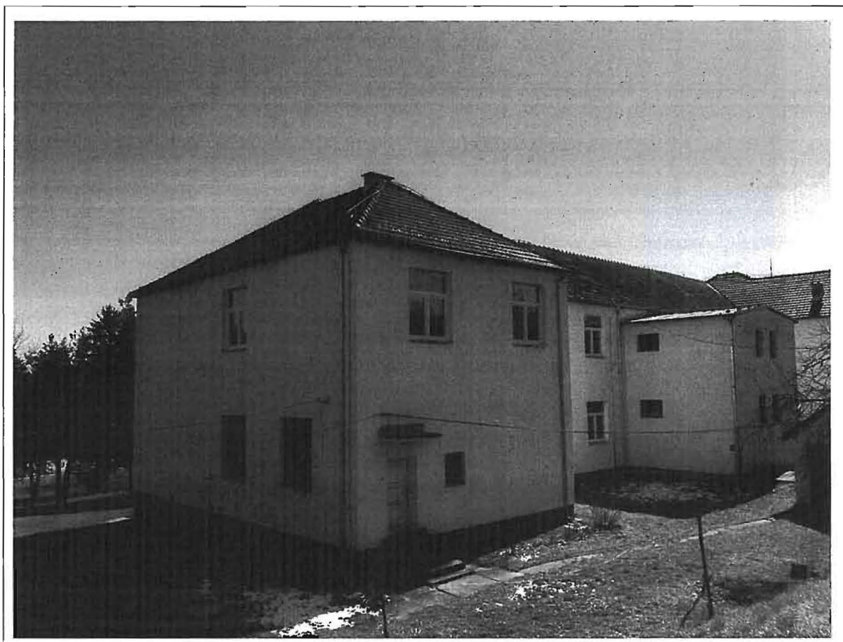
Фотографије фасада објекта
