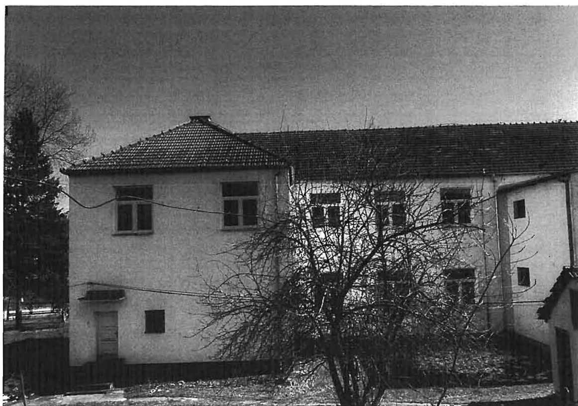
Фотографије фасада објекта
